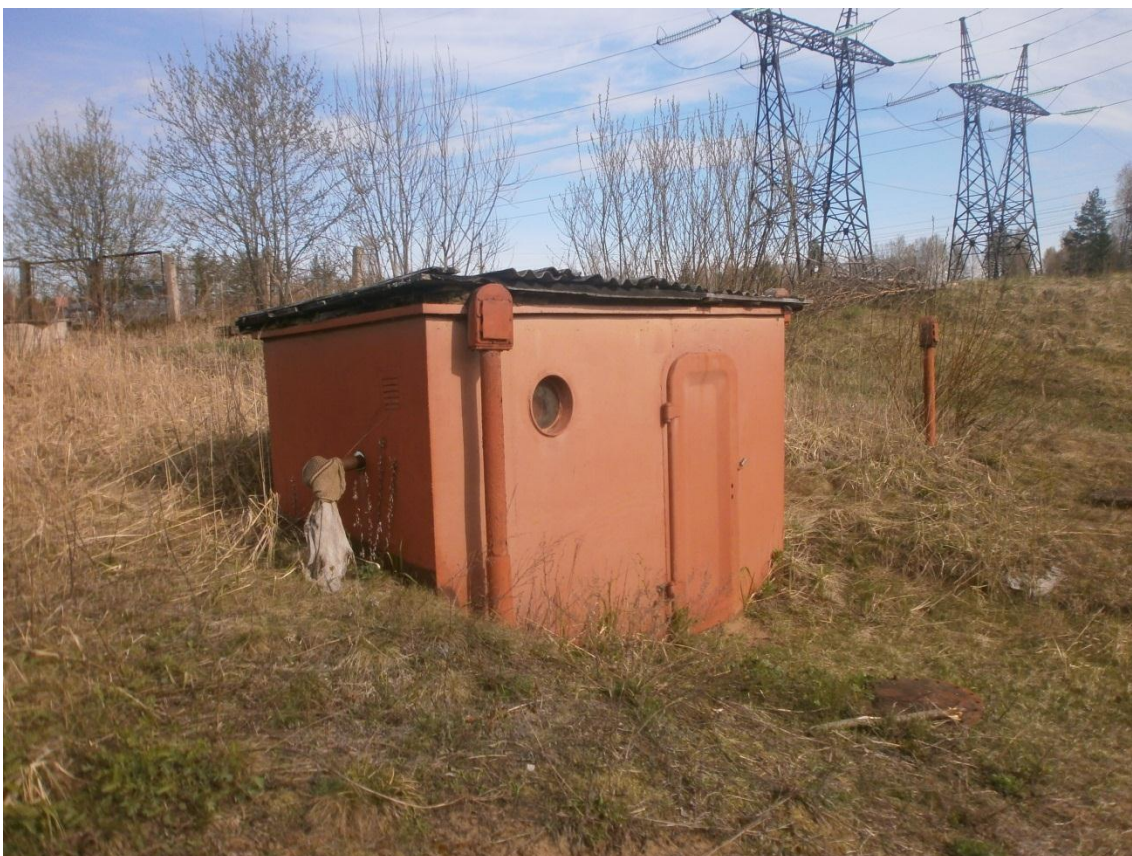
Рисунок 4. Здание существующей КНС.
